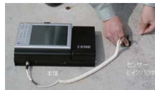
弾性波レーダーによるコンクリート検査
