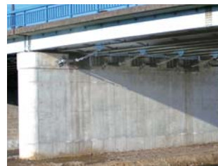
耐震対策後(落橋防止装置)
