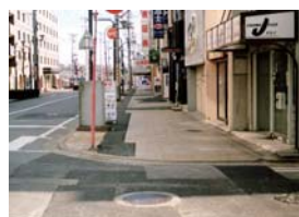
施工前(いわき市平)
