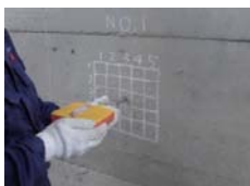
シュミットハンマーによるコンクリート強度調査
