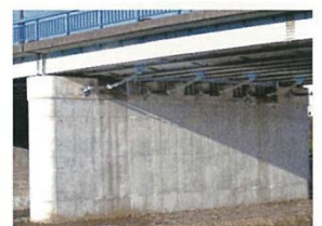
耐震対策後(落橋防止装置)
