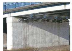
耐震対策後(落橋防止装置)
