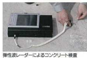
弾性波レーダーによるコンクリート検査
